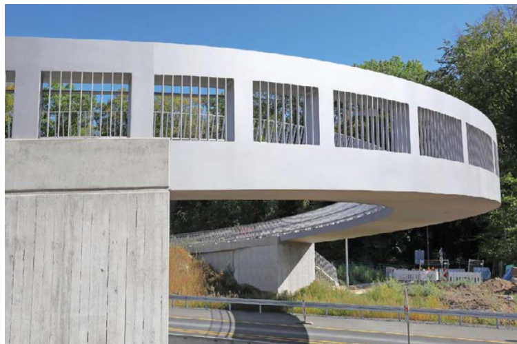
Ersatzneubau Brücke Freischütz , Schwerte
