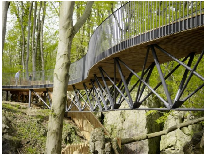
Neubau Fußgängerbrücke Felsenmeer in Hemer
