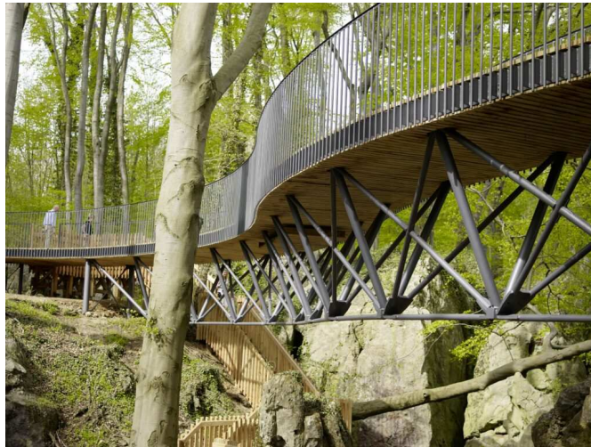
Neubau Fußgängerbrücke Felsenmeer in Hemer
